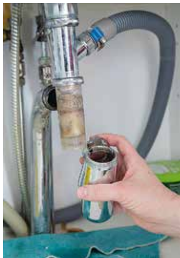
Golvbrunnar, vattenlås och ventilationens frånluftsventiler måste rengöras regelbundet.
