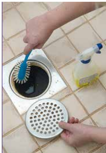
Golvbrunnar, vattenlås och ventilationens frånluftsventiler måste rengöras regelbundet.
